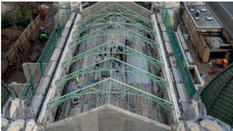
Abb. 64: Das Arnulf-und-Elizabeth-Reichert-Haus vor Einbau des Folienkissendaches. Arnulf and Elizabeth Reichert House before fitting the membrane roof.
