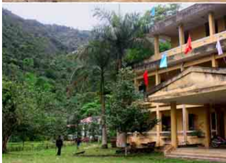
Abb. 6: Die Amphibienstation Hanoi muss neuen Bauprojekten weichen, wie oben auf dem Bild ersichtlich; mit dem Umzug der Amphibienhaltungen in die am Waldrand gelegene Me Linh Biodiversitätsstation wurde bereits begonnen.
