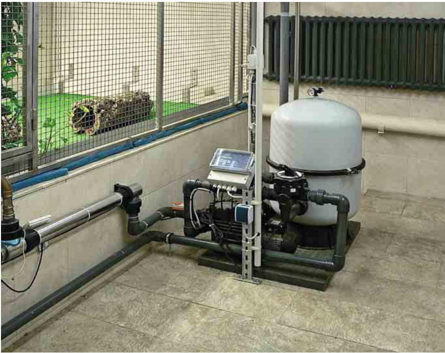
Abb. 5: Die aufwändige Wasseraufbereitungstechnik der Kölner „Off-Exhibit“-Haltung für Philippinenkrokodile. The complex water treatment system of the off-exhibit enclosure for Philippine crocodiles at the Cologne Zoo Aquarium. (Foto: D. Karbe)
