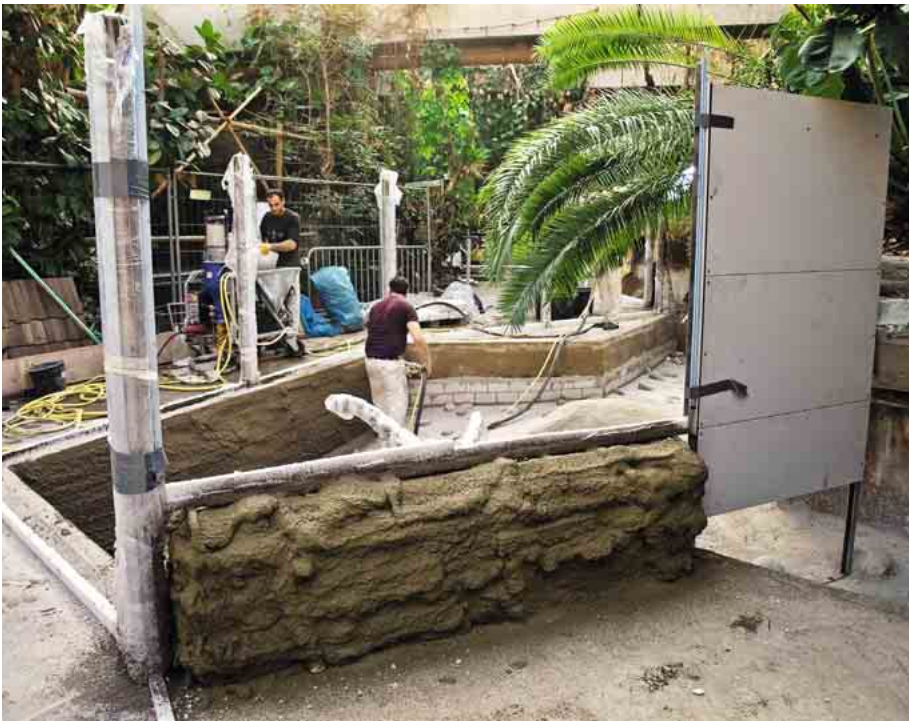
Abb. 26: Die Innenseiten des Flusslaufes werden mit einer großen Spritzpistole naturalistisch beschichtet. The inner surface of the stream course is naturalistically emulsified with a large spray pistol. (Foto: D. Karbe)
