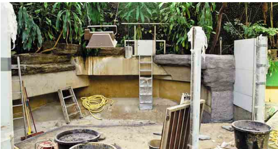
Abb. 27: Im Hintergrund des Mittelteils der Philippinenkrokodilanlage sind die beiden später noch zu kaschierenden Pfortertüren erkennbar; mittels Einhängeleitern (hier gerade im Einsatz) kann so die Anlage von hinten betreten werden. In the background of the central enclosure of the Philippine crocodile exhibit, the doors towards the keeper's area are still discernible, but will be later covered; the enclosure is accessible from the keeper's area with replaceable ladders, demonstrated in this photograph. (Foto: T. Ziegler)
