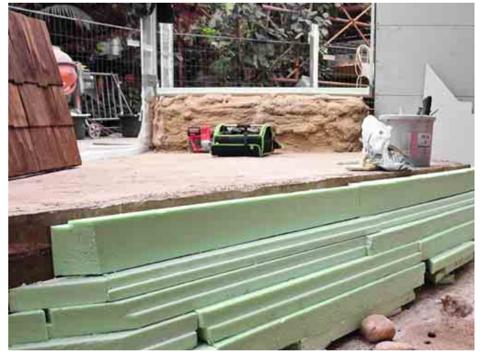
Abb. 25: Neben dem Schieber ist bereits die Kunstfelsstruktur erkennbar, die eine weitere Glasscheibe tragen wird; Fels und Flussbett werden mit Styrodur modelliert bzw. nachbearbeitet.
