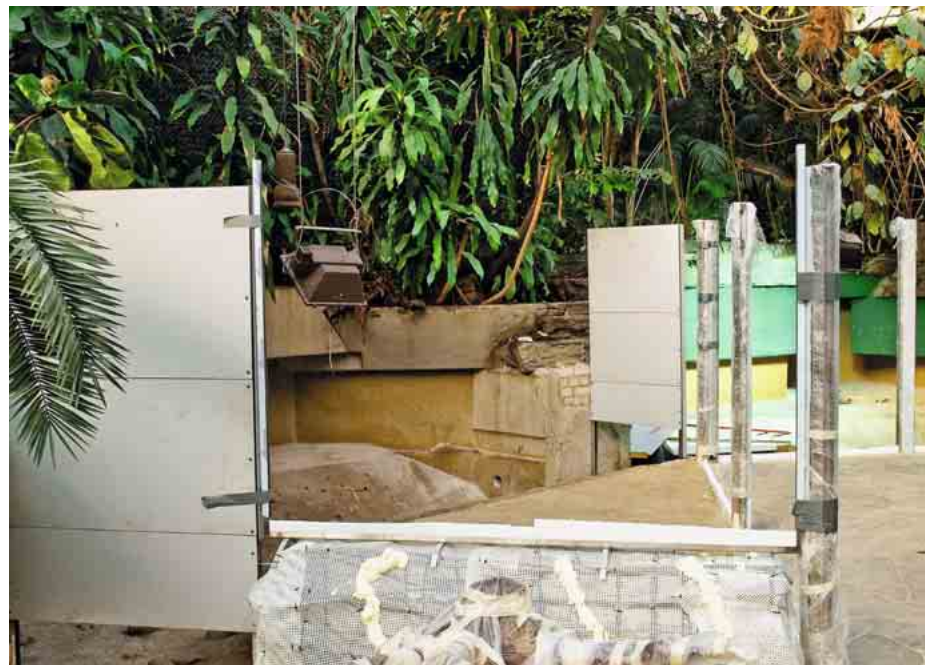
Abb. 24: Die ehemals für Besucher zur Verfügung stehende Bodenfläche ist hier bereits zum Mittelteil der Philippinenkrokodilanlage dazugekommen; ebenfalls links und rechts erkennbar die Schieberstrukturen zu den daneben befindlichen Teilen der Krokodilanlage; die durch Moniereisen geformte Felsstruktur im Vordergrund ist bereits mit Gewebe umspannt und eine Wurzel darin eingearbeitet.
